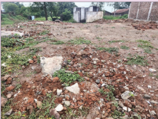
जर्जर भवन जमींदोज होने के बाद स्थिति जस की तस, नए भवनों का इंतजार
